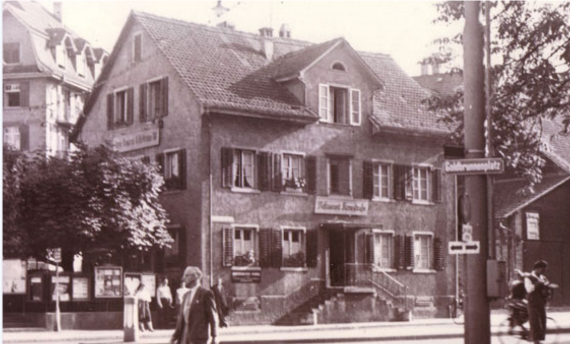
Ehem. Rest. Kreuzplatz, Goldbrunnenstraße, 8003 Zürich (1957)
